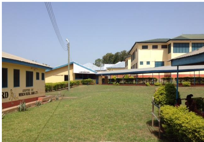
Links achteraan de nieuwe polikliniek met een overdekt gangpad naar de verpleegafdelingen.
