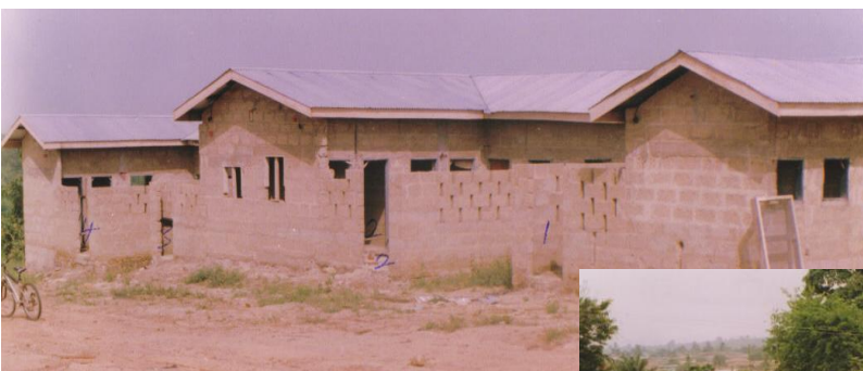
Er wordt hard gebouwd aan drie nieuwe duplex- woningen voor het verplegend personeel (boven)
